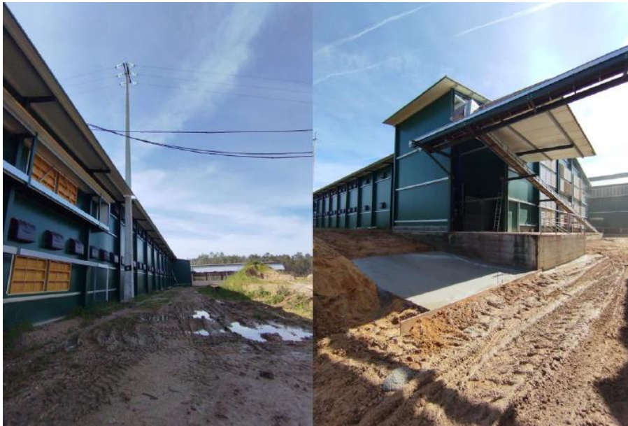
Figura 11: Evidências da necessidade de "valas" para encaminhamento das águas pluviais. Fonte: Imagens captadas durante a visita de reconhecimento ao local em 12 de março de 2024 (Neves, 2024).
